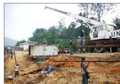
Travaux de réhabilitation de la route détruite par un éboulement sur l'axe Bunyakiri-Hombo. Crédit: Cluster Log.
